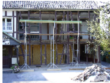
Abstützung der Deckenbalken, entfernen der Balken
