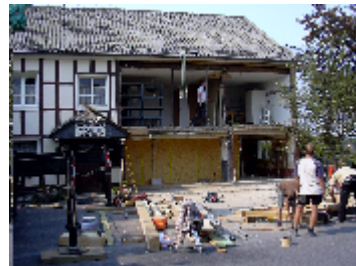
Vorbereitung zum Einsetzen des unteren Fachwerks
