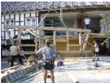
Einsetzen des Fachwerks
