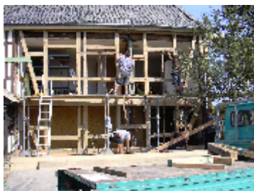
Einsetzen des oberen Fachwerks und Beginn des Ausmauerns.
