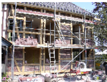
Einsetzen des oberen Fachwerks und Beginn des Ausmauerns.
