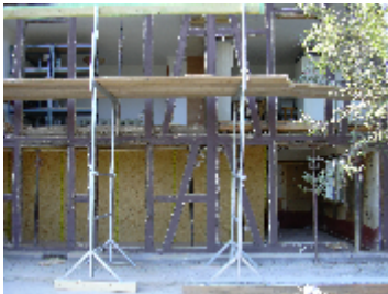
Abstützung der Deckenbalken, entfernen der Balken
