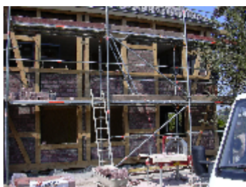
Ausmauern des Gefaches durch die Firma Peters.
