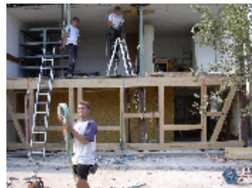
Einsetzen des Fachwerks
