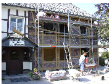
Ausmauern des Gefaches durch die Firma Peters.
