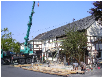
Vorbereitung zum Einsetzen des unteren Fachwerks
