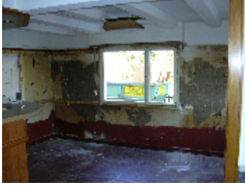
Demontage des Mauerwerkes
