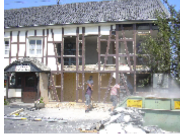
Demontage des Mauerwerkes
